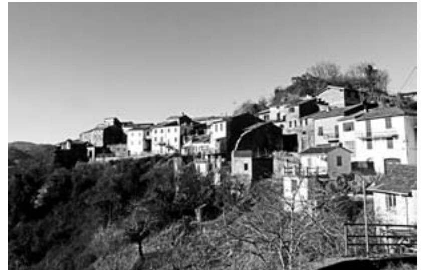
2. Ripalta (Borghetto Vara). Visione Sud/Ovest del borgo attuale (fonte: Marcella Giorgio)
