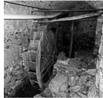
18a. La ruota verticale più recente del mulino di Travo, risalente al XVII-XVIII secolo. b. La gora che riconduce l'acqua usata per attivare la ruota del mulino verso il torrente Travo, Carro (foto M. Baldassarri)
