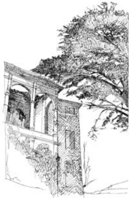
9. Il loggiato della villa prima dei restauri (fonte: Roberto Ghelfi)
